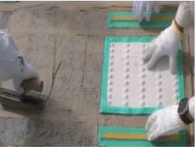
③ ④ 接着剤をクシメゴテで均一に塗布 プレート裏面にエア溜まりが出来ない ように圧着
