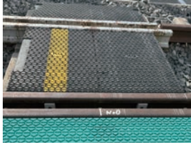
① 清掃・墨出し
