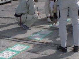
① 設置個所の清掃、墨出し後 マスキングを行い位置合わせ
