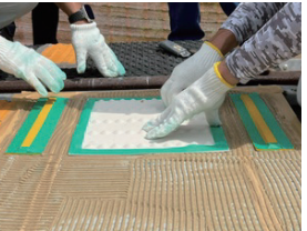
⑥ ⑦ 接着剤混合・塗布/プレート貼付け
