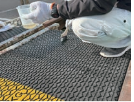
④ プライマー (接着剤) を塗布
