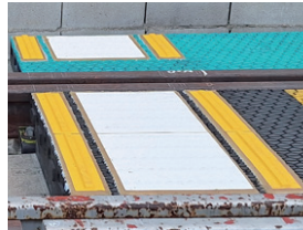
⑨ ⑩ 養生を撤去後、硬化・完成
