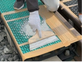
⑤ 中間補強剤塗布
