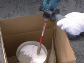
② 主剤に骨材、規定量硬化剤を投入し、 攪拌機でよく混合
