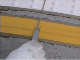
⑤ プレート外側目地と、つなぎ目地の 接着剤をヘラで仕上げ (プレートの上に落とさないように注意)
